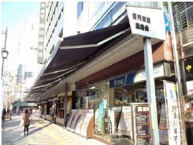
【商店街におけるオーニングの設置】
