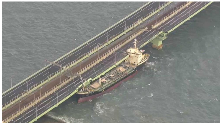
2018年9月 台風21号(大阪関西空港)
