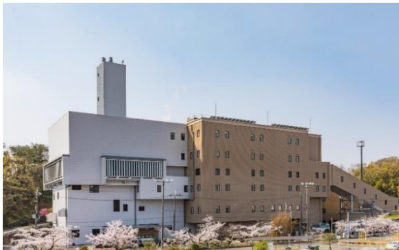
図 1-12 寝屋川市クリーンセンター
