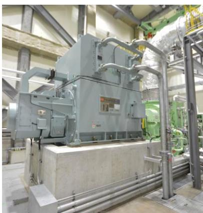
図 1-14 ごみ発電(蒸気タービン発電機)
