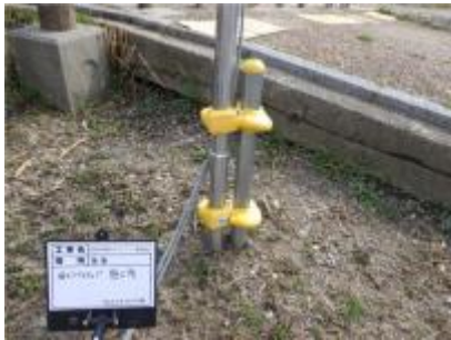
単管パイプ接続
