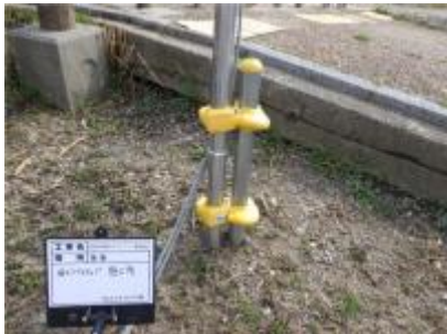
単管パイプ接続
