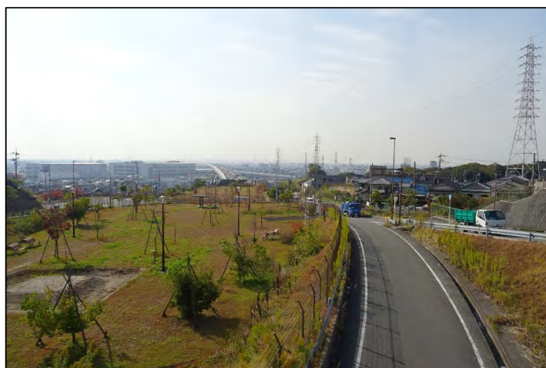
第二京阪道路上の寝屋川第2トンネル北縁地から南方を望む
