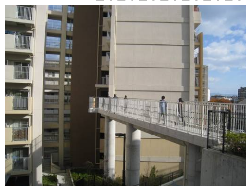
敷地高低差を活かした通路
