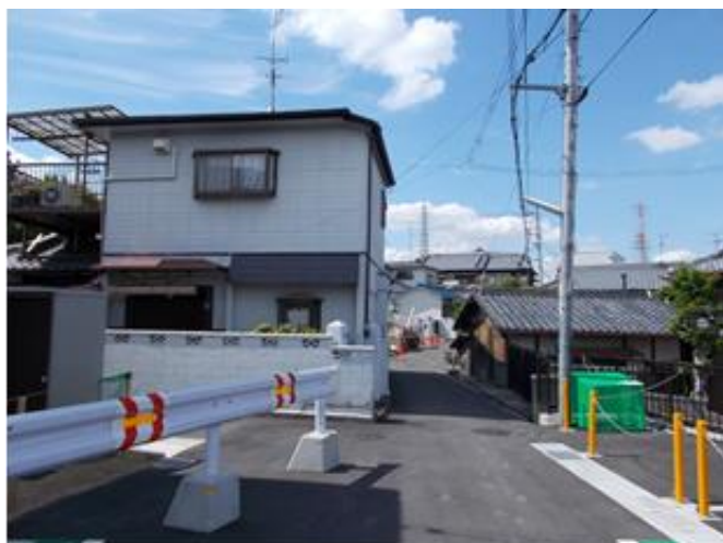
写真② 拡幅道路部分 (整備前)
