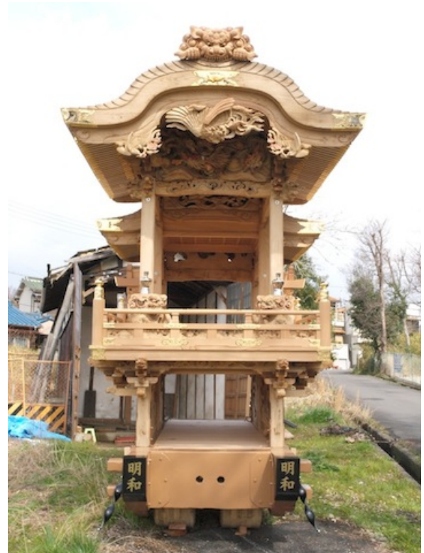
修理後のだんじり
