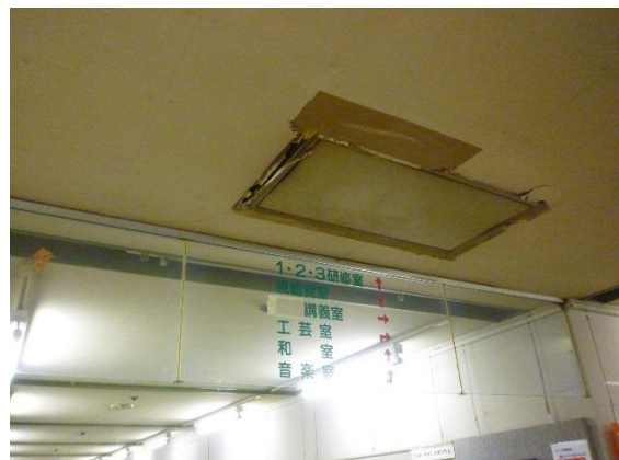
(右：4階天井の損壊部分を養生)
