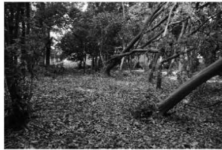
写真 81 台風 12 号の被害状況 (金堂東側)
