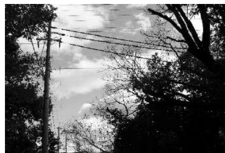
写真 52 樹木に覆われた電線
