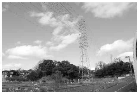
写真 51 鉄塔（南西から）
