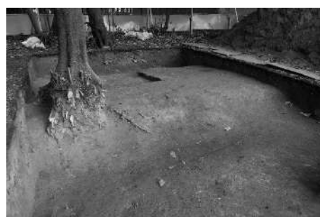
写真 36 東面築地塀基底部（北西から）
