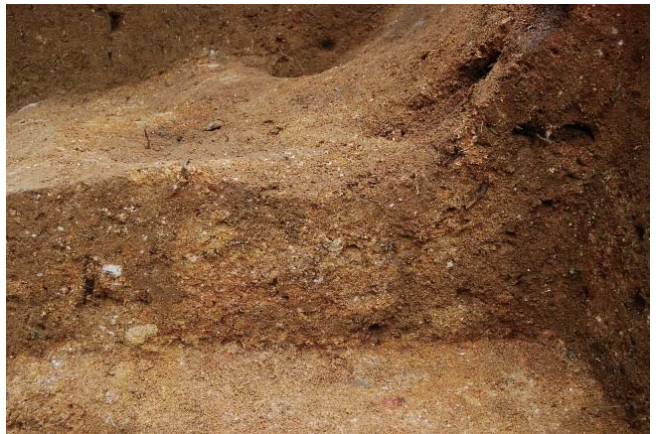
写真6 中門基壇の版築状況
