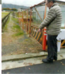
移設工事後の状況を確認する担当委員
